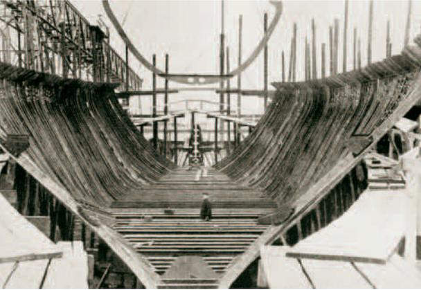
Abb. 7: Spantengerüst von achtern.
